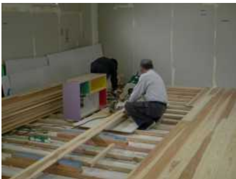
1月13日（金） 床はまもなく完成
