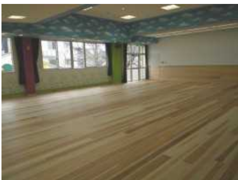
1月30日（月） ホールの改修工事が完了しました
